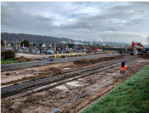
Les travaux se poursuivent pour l'extension du cimetière. L'entreprise a installé des dalles végétales et a aménagé des allées. Le remblaiement de l'entrée précédente a été réalisé. La pose des enrobés et des pavés en béton est prévue dans les semaines à venir.
